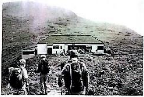
仙生小屋(九台目)
